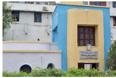
Pa y & Use Toilet
